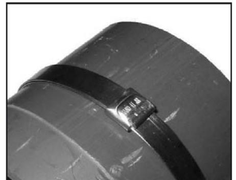
9. Die Schelle wird fertiggestellt, indem man den Rand des Bandes über der Schlaufe verhämmert. Der Ratschenschlüssel wird wie unter 6. gezeigt entfernt.
